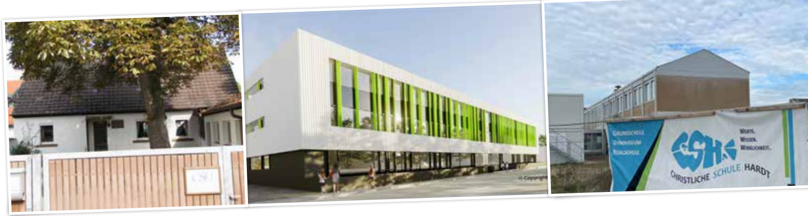
Von Links nach Rechts: AB-Gemeinschaftshaus | Geplanter Neubau | Aktuelles Gebäude
